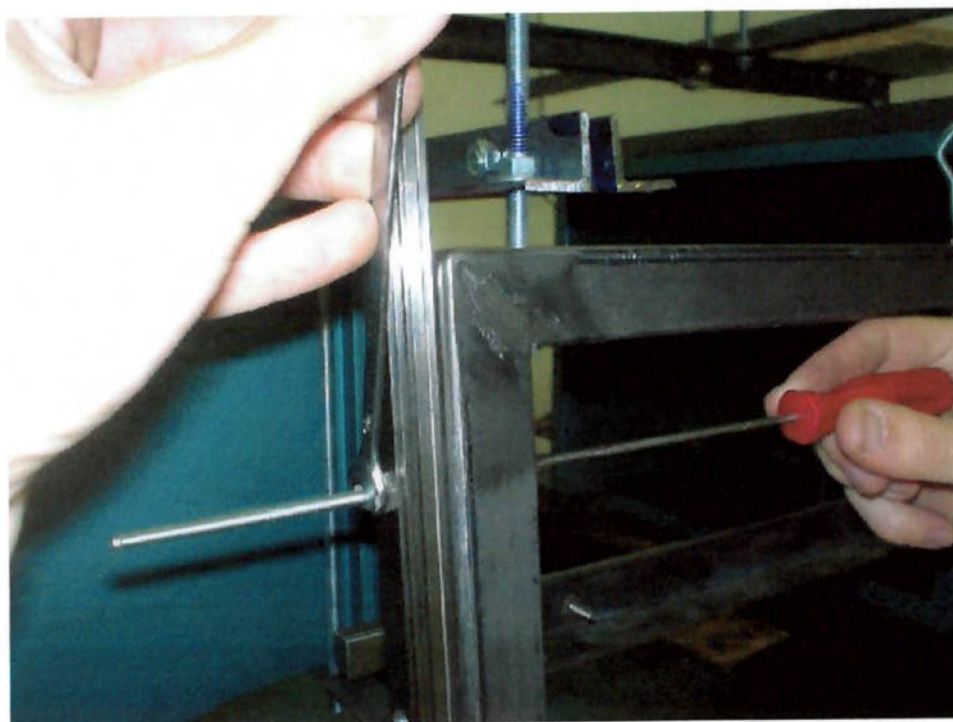
Fig. 4.5.2.21 – Parafusamento da guia linear vertical no quadro
